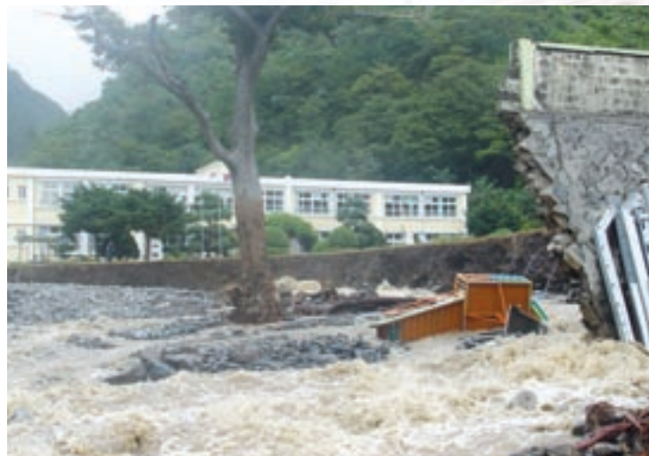
태풍 '나비'로 인한 ▶ 폭우로 유실된 제방의 모습.
