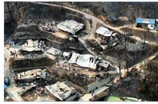
경북 울진군 북면 산불 피해 사진
