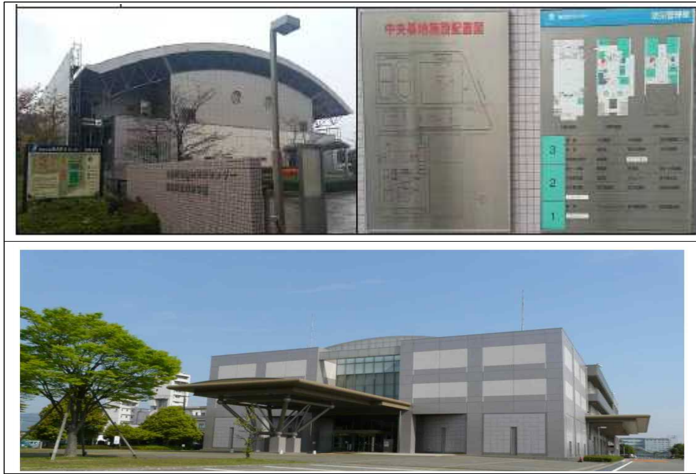
<그림 III-16> 가나가와현 종합방재센터 건물 전경
