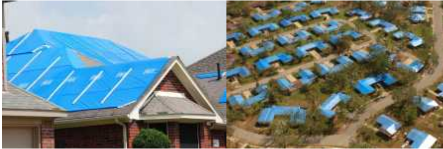
그림 3.7 카트리나 이후 Blue Roof 설치(Biloxi, Mississippi) 1)
