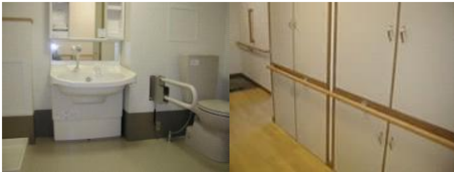
그림 3.10 시즈오카현 공영아파트의 유니버설 디자인 도입 사례 23) ( 복도에 손잡이 설치 , 휠체어 대응 화장실 )
